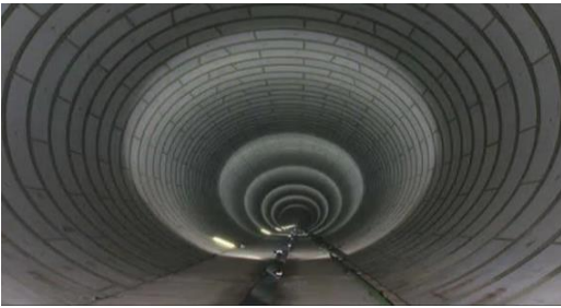
도쿄도 빗물 터널 (방수로) 상하폭 12 m, 원형 형태, 길이 4.5 km
