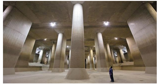
도쿄 인근 사이타마현 빗물 터널 (방수로) 상하폭 18 m, 직사각형 형태, 길이 6.3 km
