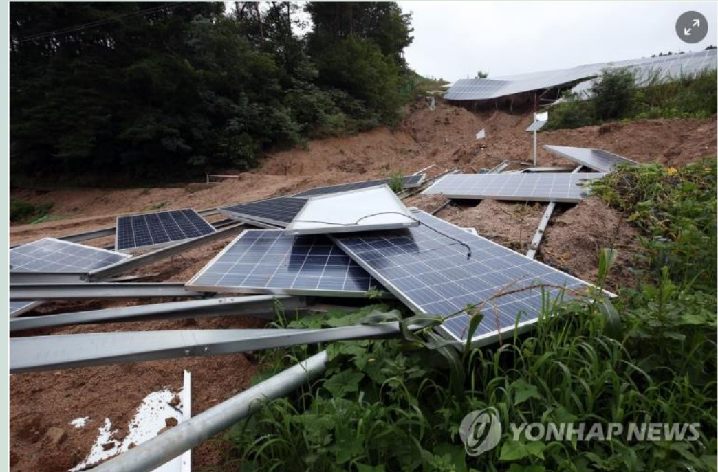
지난해 8월 발생한 충북 제천시 대량동 태양광 설비가 산사태 사고.(사진=연합)
